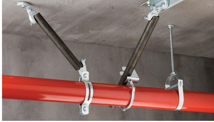
Şekil 26. Yangın Sistemleri Deprem Koruması
